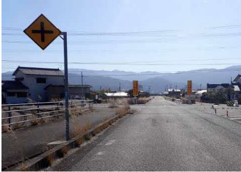
【NO.24+10付近(左側)】
