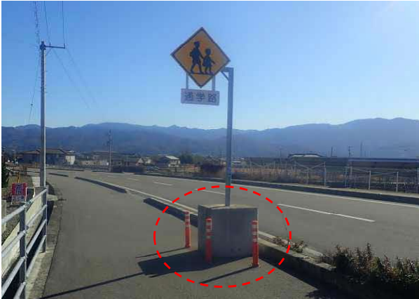
NO.71+10付近(左側)
